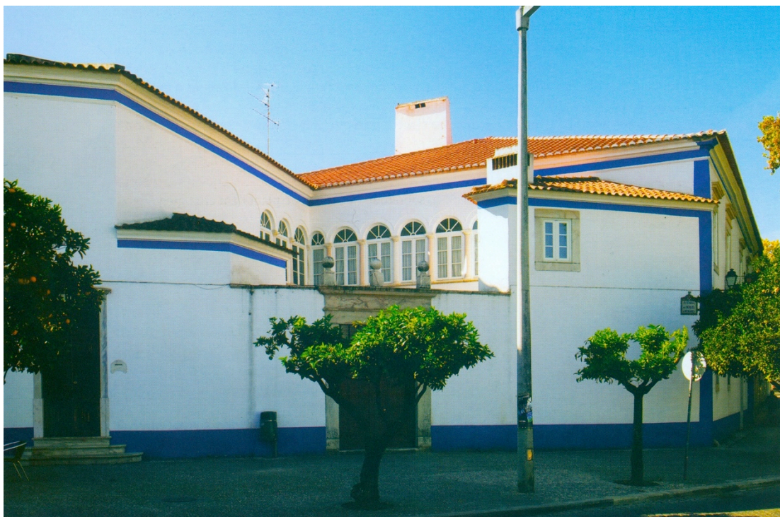
Figura 182. Vila Viçosa, Paço dos Lucenas, fachada principal; na retaguarda um loggia renascentista (hoje preenchida com janelas). Fonte: DGPC: SIPA.
