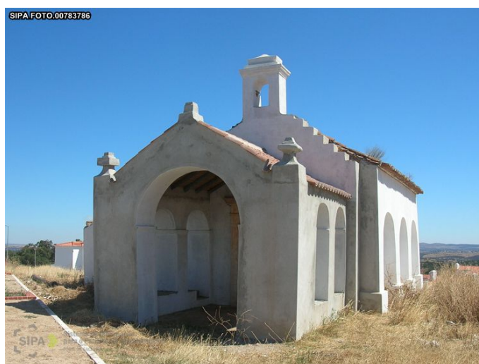
Figura 168. Vila Viçosa, Igreja ou Ermida de S. Domingos (Foto DGPC:SIPA 00783786)
