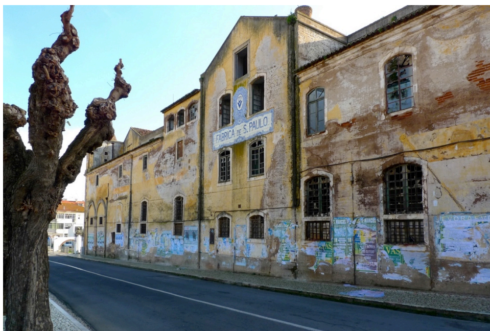
Figura 167. Vila Viçosa, Convento de Nossa Senhora do Amparo, ou de S. Paulo, ou Fábrica de São Paulo. Foto FL, 2014.
