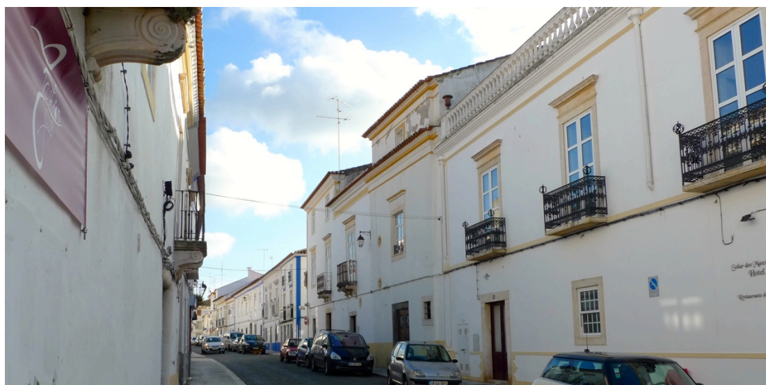
Figura 32. Vila Viçosa, o desenvolvimento urbano quinhentista. Atual Rua Florbela Espanca (antes rua da Corredoura). A expansão urbana quinhentista manteve-se até aos nossos dias, quer pela preservação do plano urbanístico, quer pela conservação dos edifícios mais importantes (palácio ducal, igrejas, conventos), assim como pela preservação das características arquitetónicas essenciais dos edifícios de residência senhorial . Foto FL, 2014.
