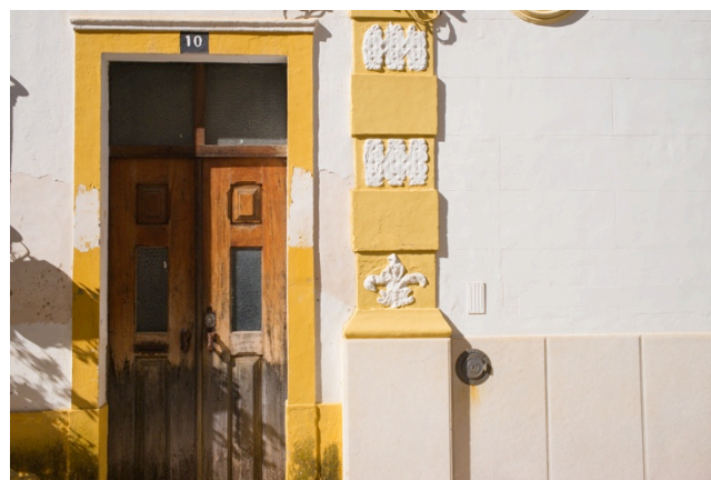
Figura 155. Vila Viçosa, Pormenores decorativos em fachadas. Fotos FL, 2018.
