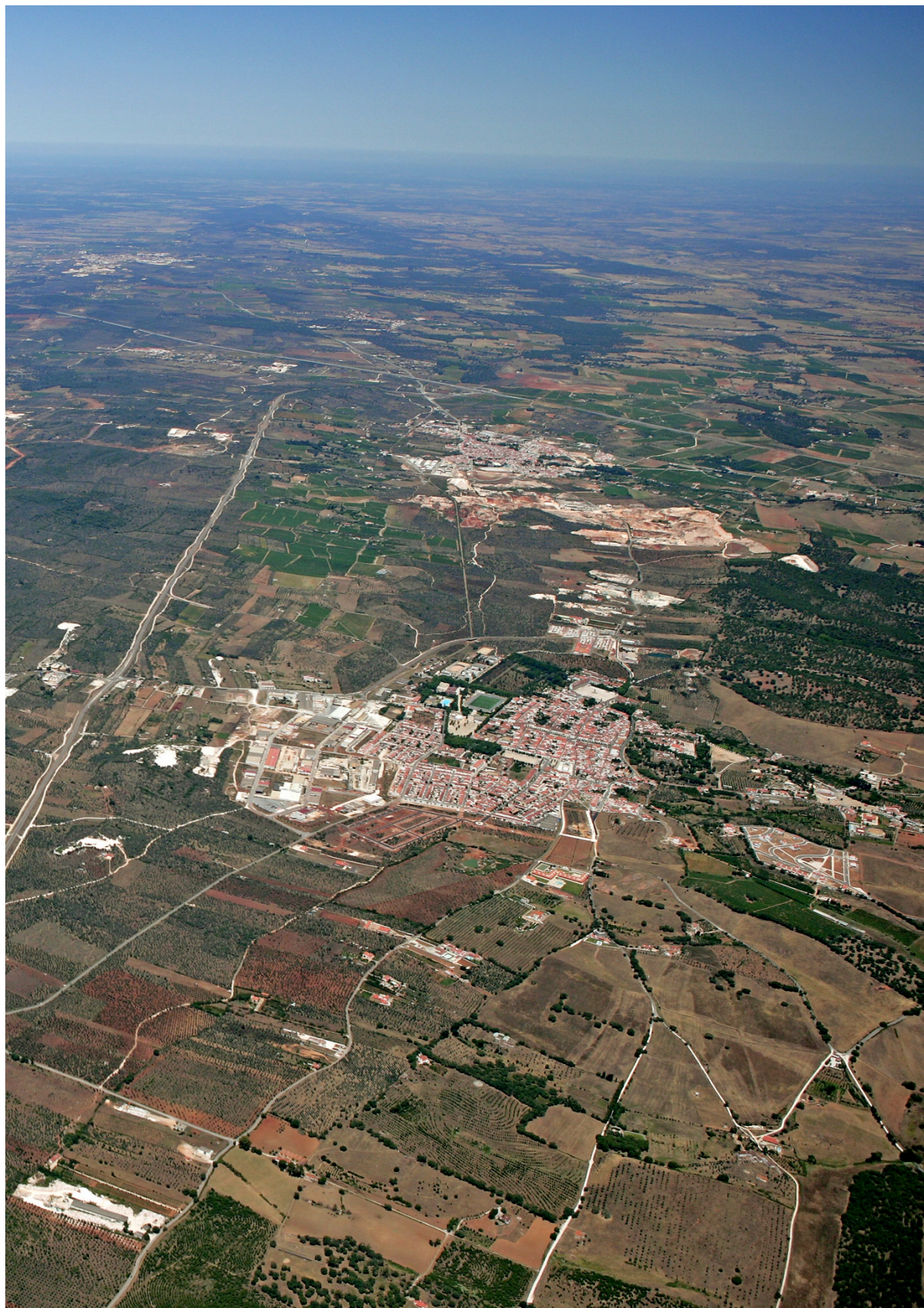
Figura 8. Vista aérea de Vila Viçosa: em segundo plano marca-se o aglomerado urbano correspondente à cidade de Borba. Foto CMVV / Francisco Piqueiro - Foto Engenho, 2007.
