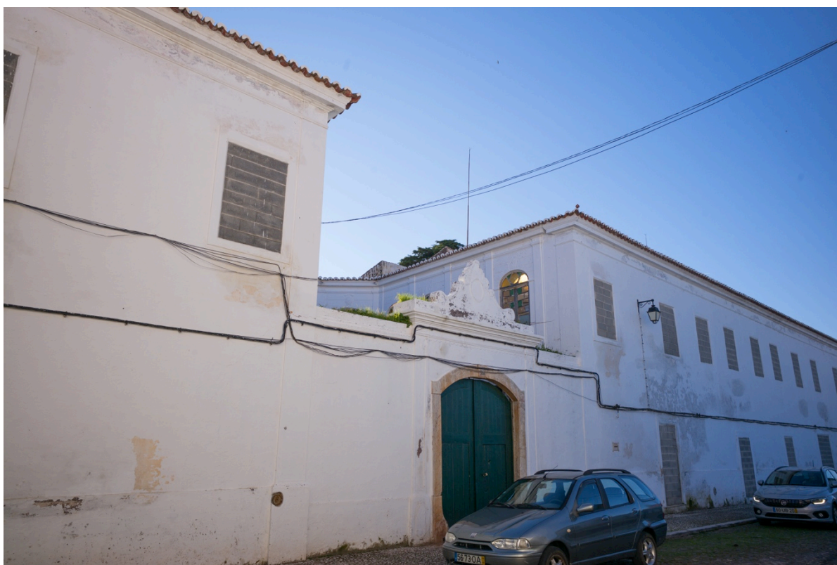
Figura 149. Vila Viçosa, Palácio dos Silveira Meneses, na Rua Dr. Couto Jardim (antes rua dos Fidalgos), n.º 9 a 11, após obras que tiveram por objetivo suspender o processo de degradação. Foto FL, 2018.
