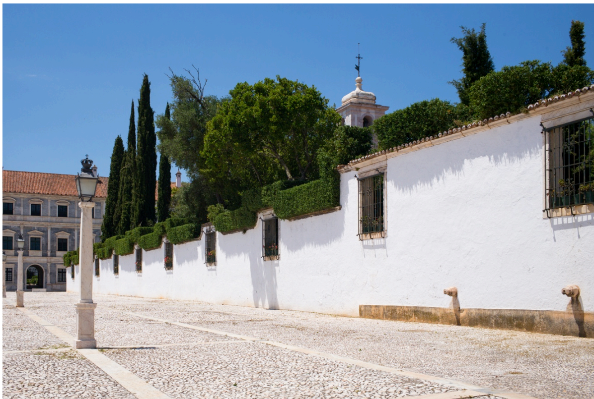
Figura 98. Paço Ducal de Vila Viçosa, muro de delimitação do jardim do Bosque, a norte, antigo Jardim da Duquesa. Foto FL, 2018.
