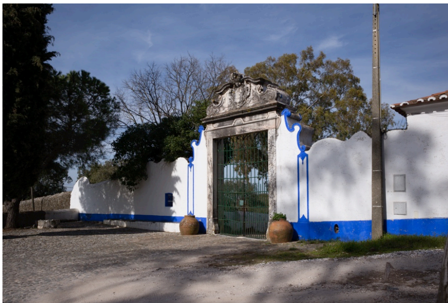
Figura 16. Vila Viçosa, Tapada Real. Porta de São Bento. Foto FL, 2018.
