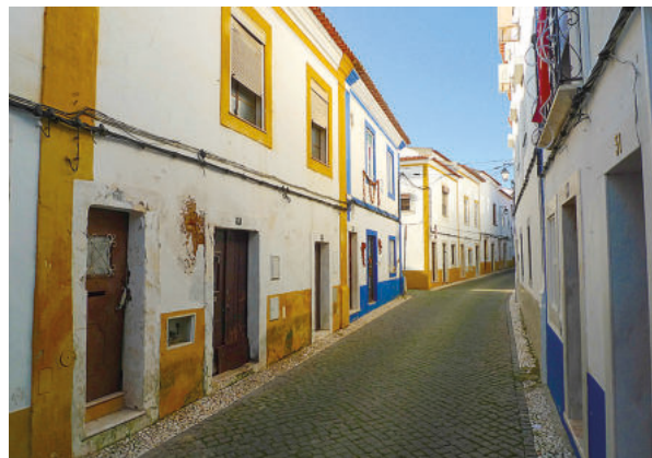
Fig. 140 – Vila Viçosa, arruamento do arrabalde extramuros, primeira metade do século XV. Atual Rua Câmara Pestana. A primeira expansão fora das muralhas realizada ao longo do século XV mantém o seu traçado original e, maioritariamente, o cadastro. Apesar das construções terem assumido uma natural evolução, esta processou-se de forma coerente, não se alterando o carácter medieval desta área. Foto FL, 2014.
