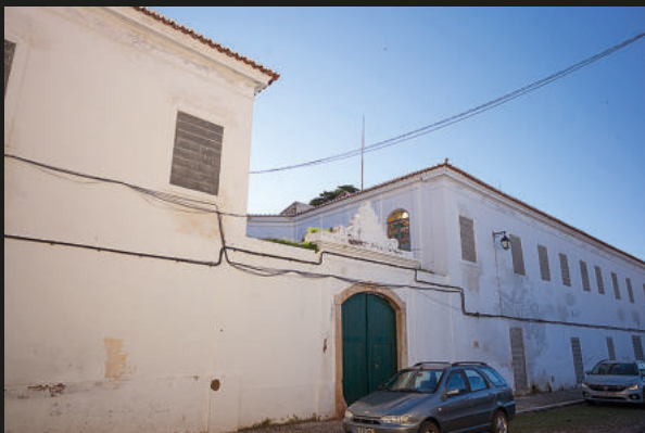
Fig. 106 – Vila Viçosa, Palácio dos Silveira Meneses, na Rua Dr. Couto Jardim (antes Rua dos Fidalgos), n.º 9 a 11, após obras que tiveram por objetivo suspender o processo de degradação. Foto FL, 2018.
