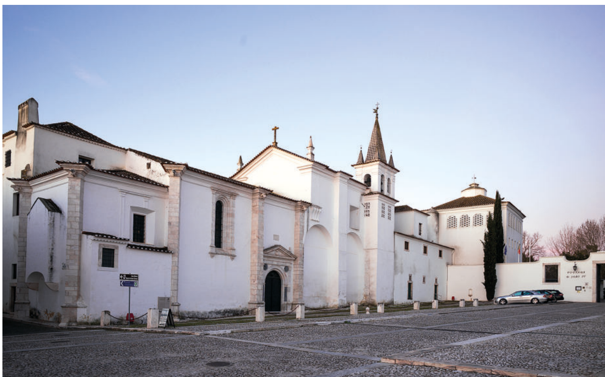
Fig. 82 – Vila Viçosa, Igreja e Convento das Chagas, fachada norte. Foto FL, 2018.
