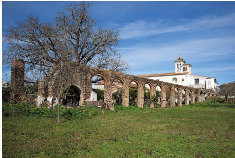
Fig. 93 – Vila Viçosa, Igreja e convento da Esperança; no primeiro plano trecho do aqueduto com arcos ao romano de volta perfeita. Foto FL, 2018.
