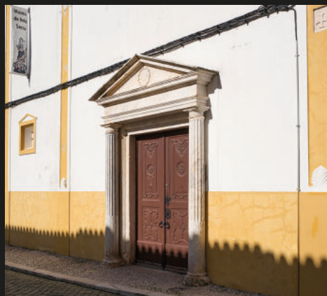
Fig. 71 – Vila Viçosa, Convento de Santa Cruz no cruzamento da Rua Florbela Espanca (antiga Rua da Corredoura) com a Rua Públia Hortênsia de Castro (antes Rua do Parlatório). Foto FL, 2018.
