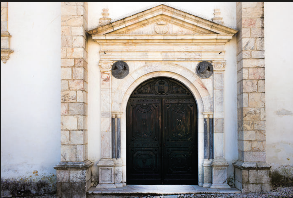
Fig. 85 – Vila Viçosa, Convento das Chagas. Portal principal, renascentista, da igreja. Foto FL, 2018.
