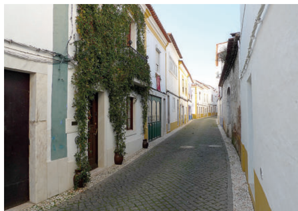
Fig. 136 – Vila Viçosa, via principal do início do arrabalde extramuros, primeira metade do século XV. Atual Rua Alexandre Herculano (antiga Rua da Freira). Foto FL, 2014.
