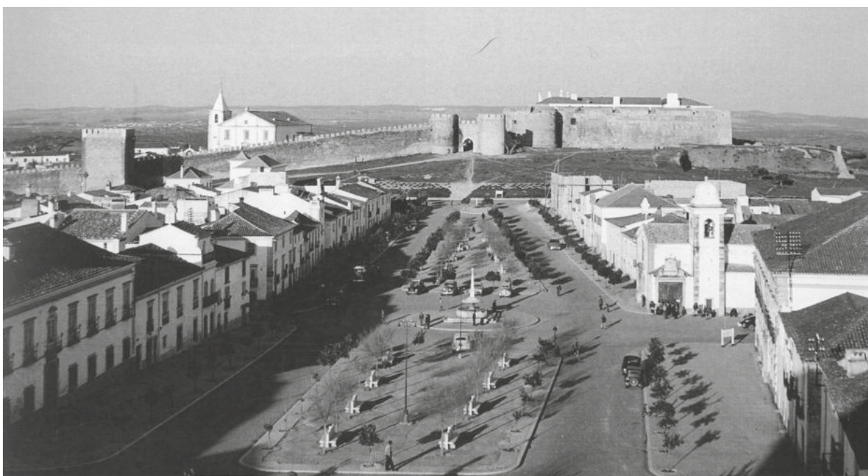
Fig. 151 – Vila Viçosa, Praça da República (antiga Praça Velha) antes da intervenção urbanística realizada na década de 1940 (fotografia de autor desconhecido). Ao fundo vê-se o Castelo e a meio, do lado direito, a igreja da Misericórdia, alinhada com fachadas de duas casas senhoriais.
